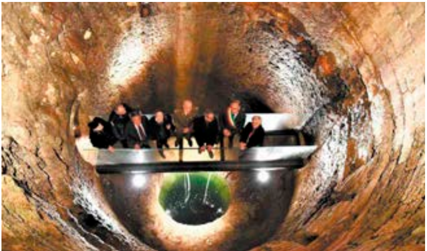
▲ Pozzo Sorbello a Perugia è un monumentale pozzo-cisterna profondo circa 36 metri, con un diametro massimo di 5,6; costruito dagli Etruschi intorno al III-II secolo a.C., era alimentato da acqua sorgiva ma raccoglieva anche l'acqua piovana, canalizzata all'interno.
